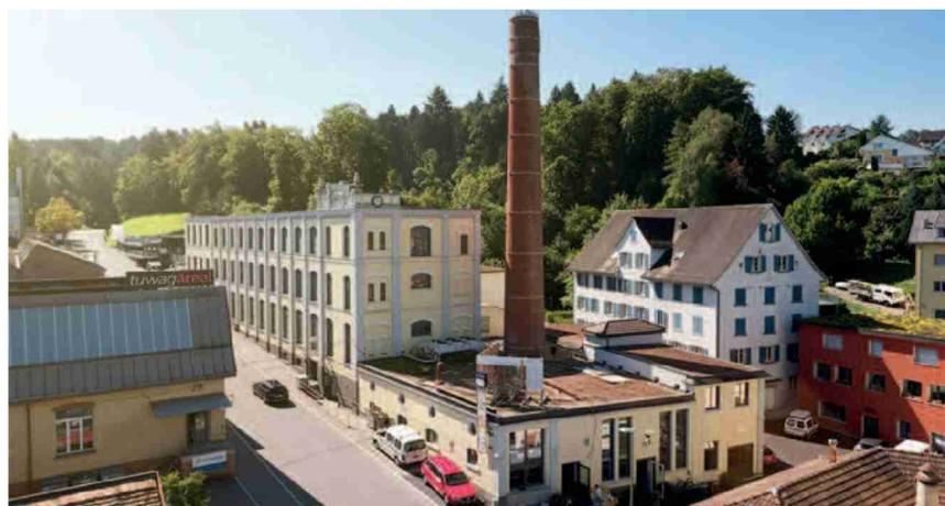
war wegen der geschichtsträchtigen Bau-substanz besondere Präzision gefragt. Der Bunker für die Holzschnitzel etwa fand seinen Platz unterirdisch zwischen zwei bestehenden Gebäuden. Den markanten Industriekamin bezog Energie 360° ebenfalls in den Bau ein: Er beherbergt nun die Rauchgasanlage des Wärmeverbunds und hat dazu eine komplett neue Innenverkleidung erhalten.
