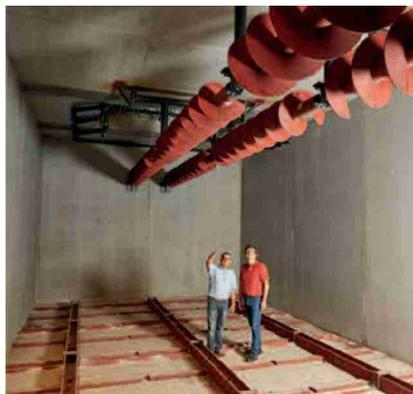
Komfortable Lösung: Dank des Schubbodens und der Förderschnecken gelangen die Holzschnitzel vom Bunker automatisch zu den beiden Heizkesseln.
