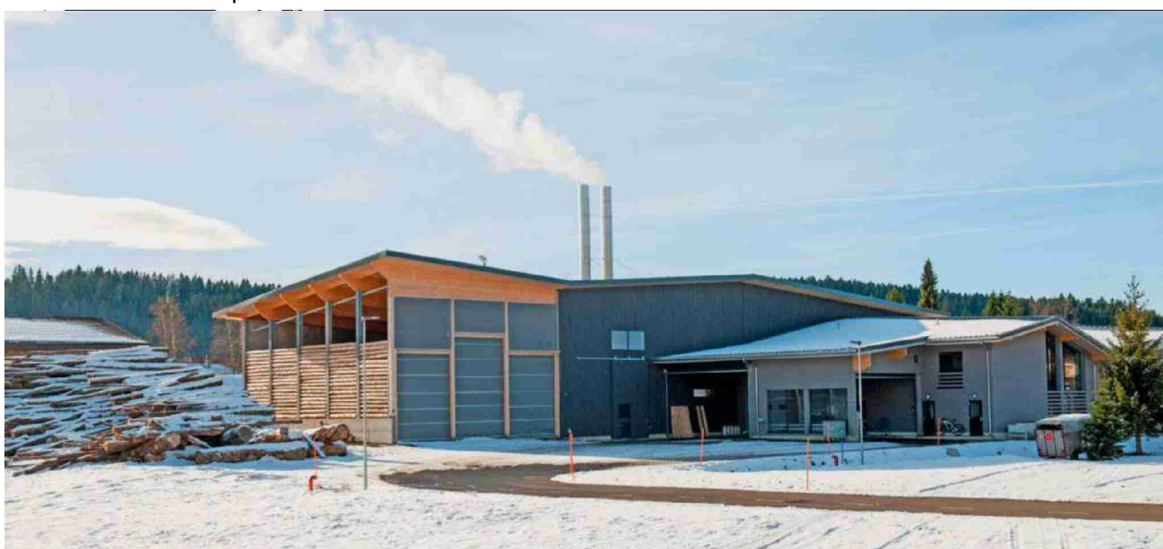
Vue d'ensemble du site de chauffage à distance et de la fromagerie.
