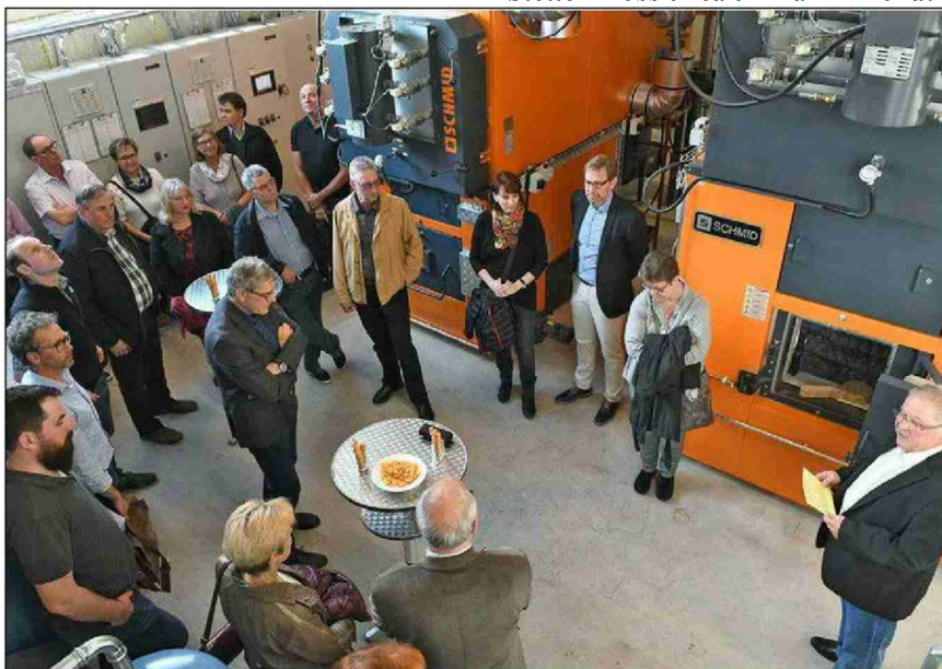
Der Blick in die Wärmezentrale mit den zwei Holzfeuerungen
