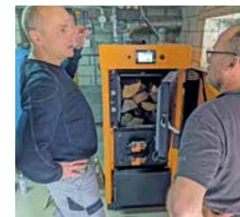
Jusqu'à présent, la ferme de la famille Aubert était chauffée par une pompe à chaleur air-eau électrique. Cependant, une autre solution a dû être trouvée étant donné que le compresseur ne fonctionnait plus. Un chauffage au bois a été préféré afin de pouvoir utiliser la propre forêt du maître d'ouvrage.
