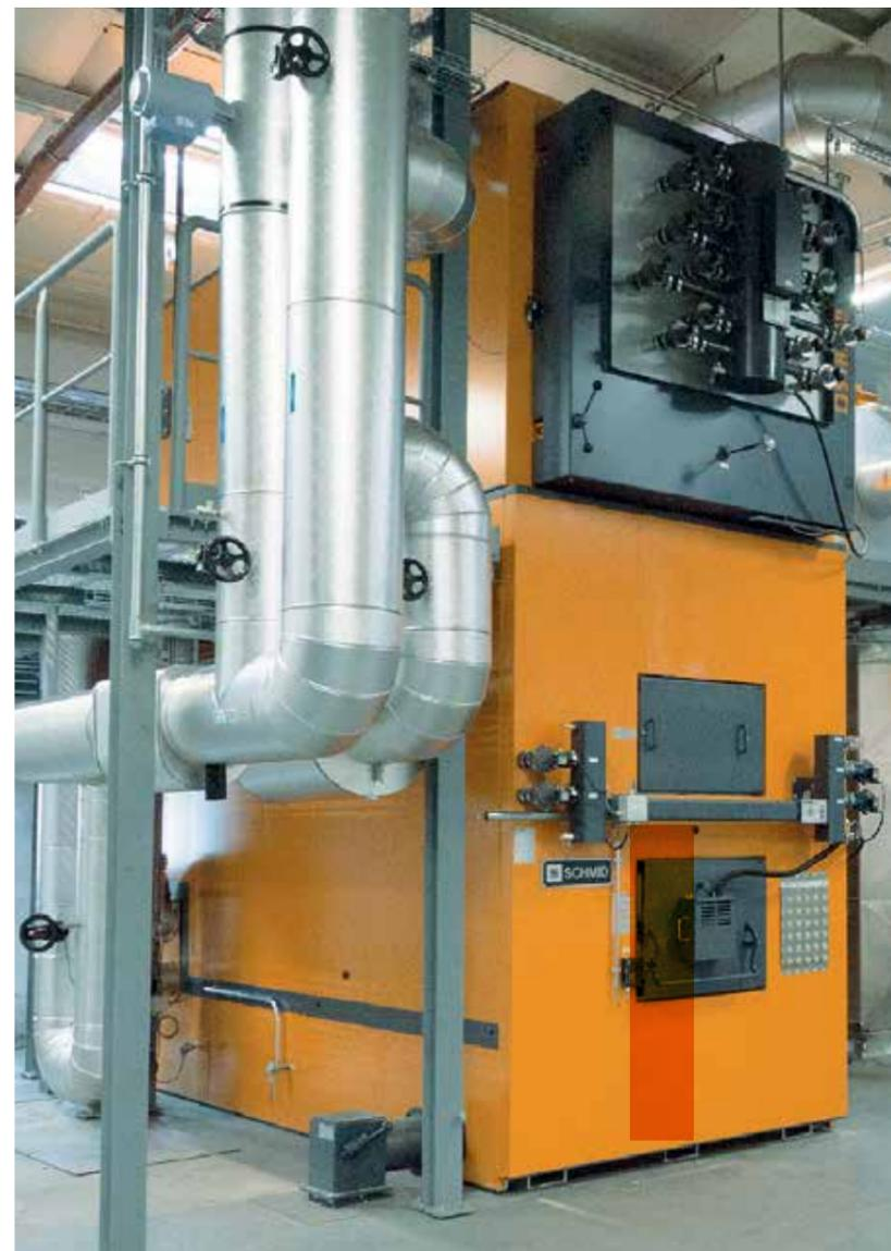
Pour la condensation, les gaz de combustion doivent être refroidis en dessous de leur température de point de rosée. En fonction de l'humidité du combustible et de la teneur résiduelle en oxygène des gaz de combustion, cette température est d'environ 45 à 60 °C. Plus les gaz de combustion peuvent être refroidis dans l'installation de condensation plus la chaleur de condensation peut être récupérée.
