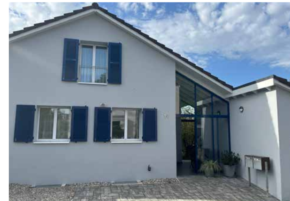
VORHER UND NACHHER: DIE BAUSTELLE ZUR FASSADENDÄMMUNG 2017 UND IM NEUEN GLANZ MIT DREIFACH-FENSTERN. FOTOS ZVG
