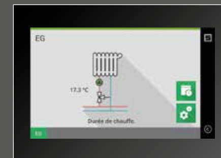
Circuit de chauffage
